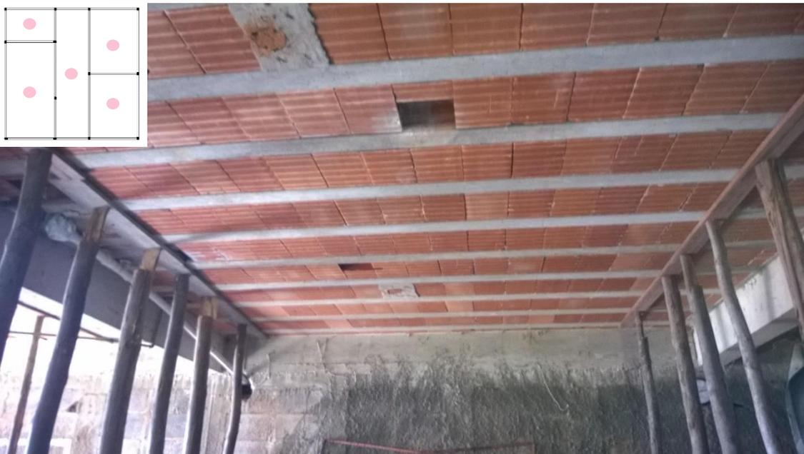
**Figura 7 – Lajotas que se soltaram, indicando uma flexão nas vigotas, possivelmente causadas pela flexão nas vigas de apoio.**
