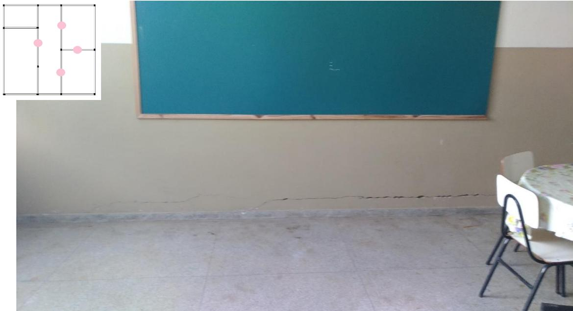
**Figura 2 – Rachadura gerada pelo descolamento.**
