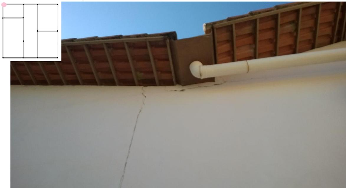
**Figura 14 - Trinca externa, na interface da estrutura sob aterro.**
