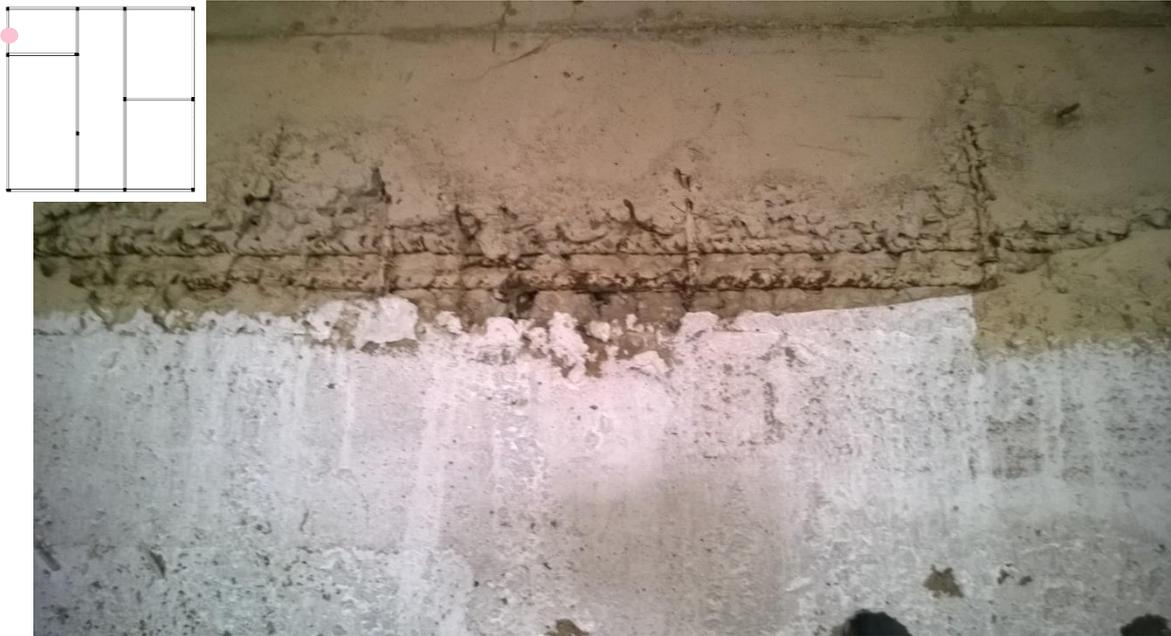
**Figura 9 – Armaduras expostas na viga de travamento e sustentação do arrimo lateral.**
