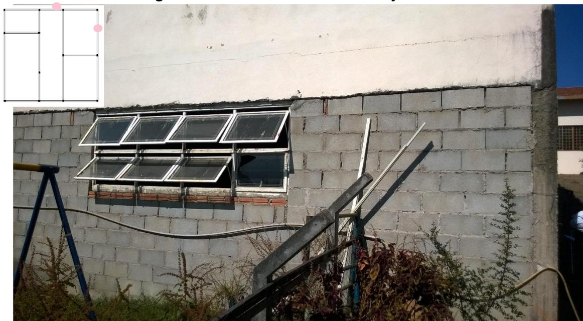
**Figura 6 – Trincas de argamassa na junção das vigas com a alvenaria superior.**
