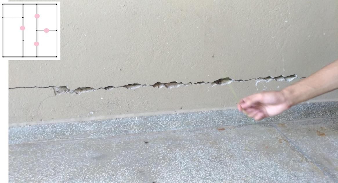
**Figura 1- Descolamento da alvenaria sob a viga.**
