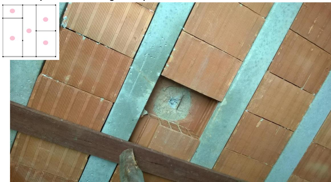
**Figura 8 – Detalhe – Lajota solta**
