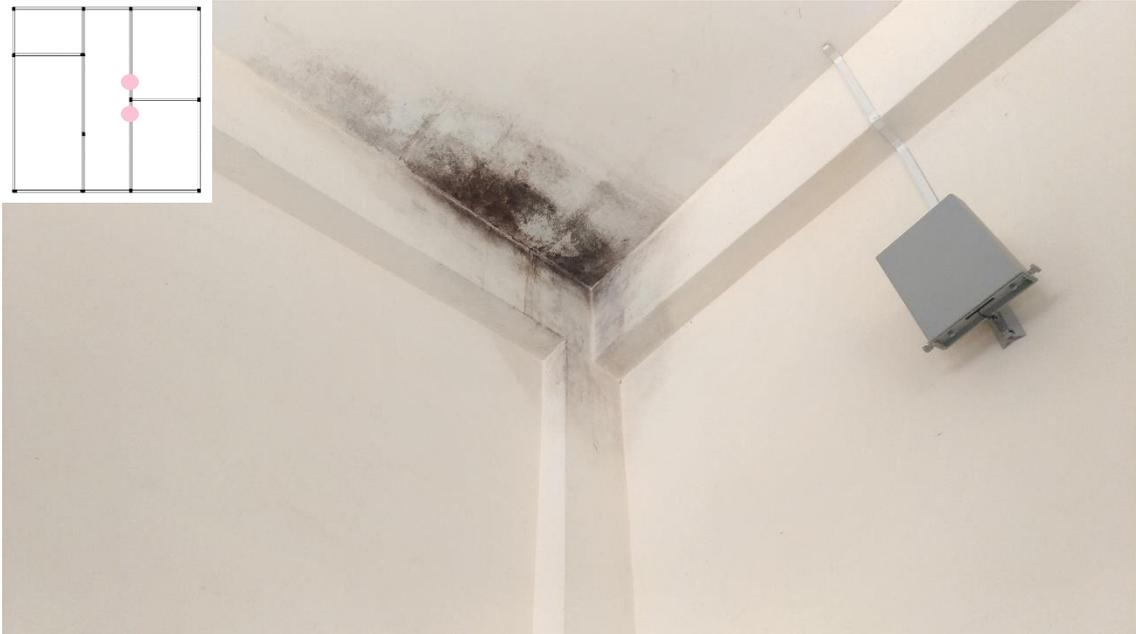
**Figura 5 - Vazamento da calha na laje de teto**
