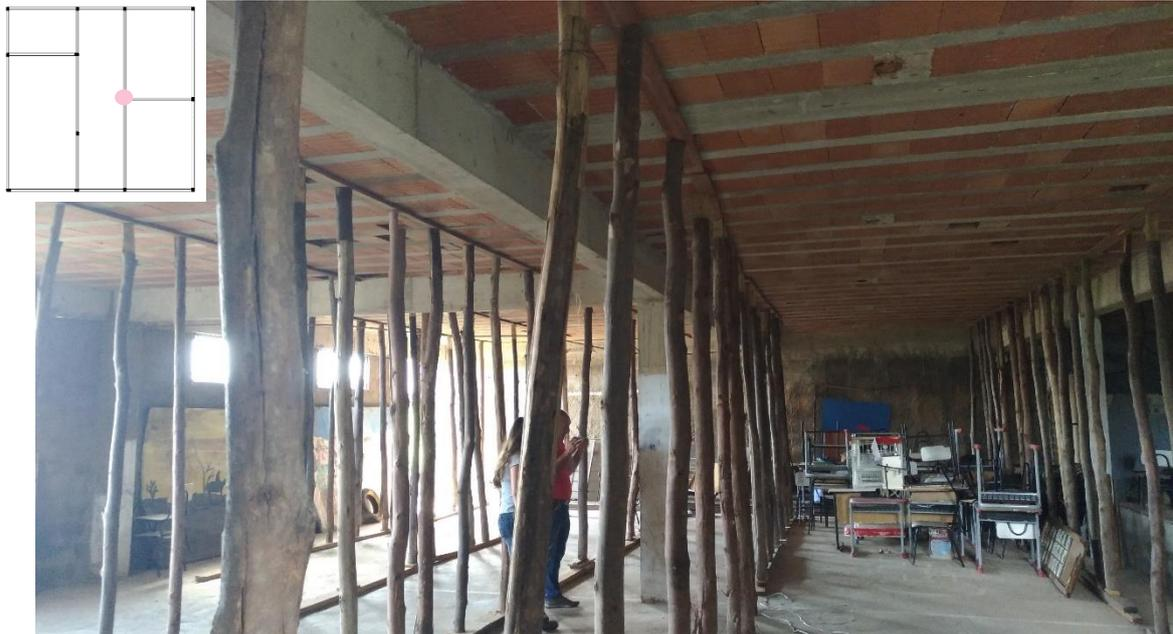
**Figura 13 – Visão Geral do Escoramento Provisório**
