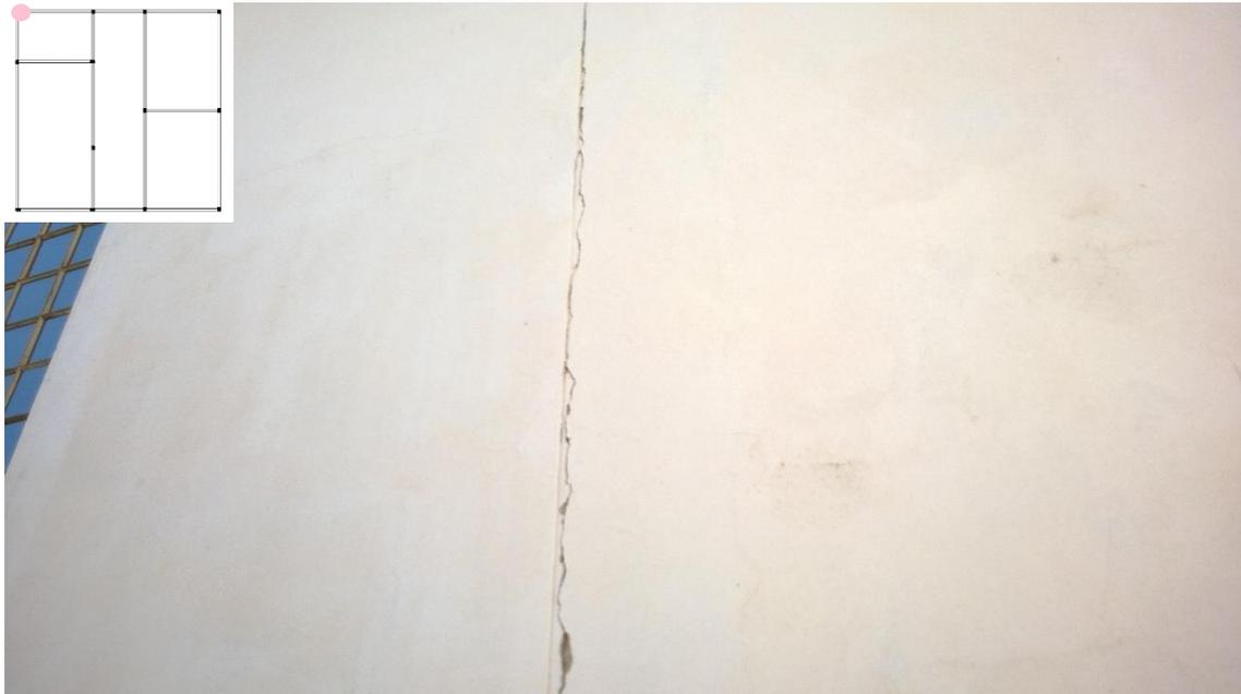
**Figura 15 - Trinca externa, na interface da estrutura sob aterro.**
